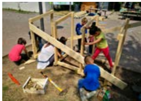
Fixation de la structure sur les fondations
